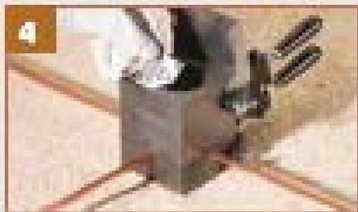
4 Verter el 50% del polvo iniciador a modo de mecha sobre el borde del molde y el resto sobre el compuesto de soldadura. Cerrar la tapa del molde.
