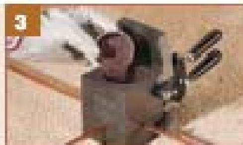
3 Vaciar el contenido del envase de compuesto de soldadura.
