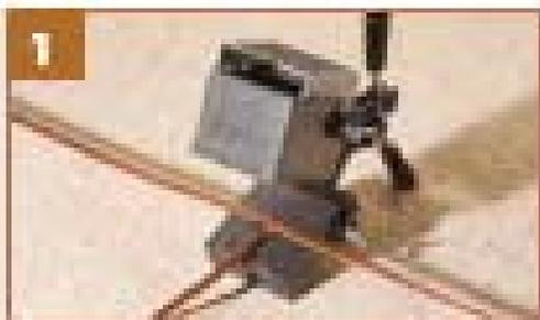
1 Colocar los conductores en el molde y cerrar las pinzas para evitar fugas de metal durante la reacción.
