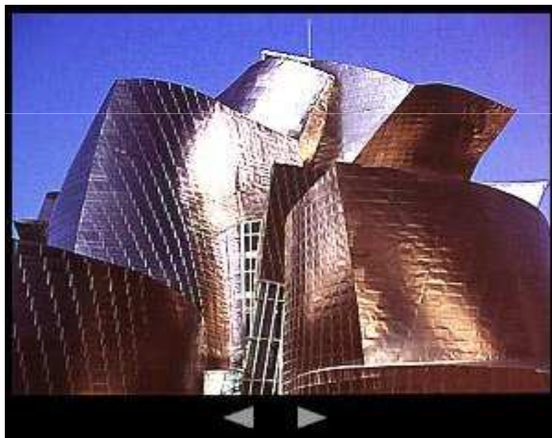
Protección mediante PDC's del Museo Guggenheim en Bilbao.
