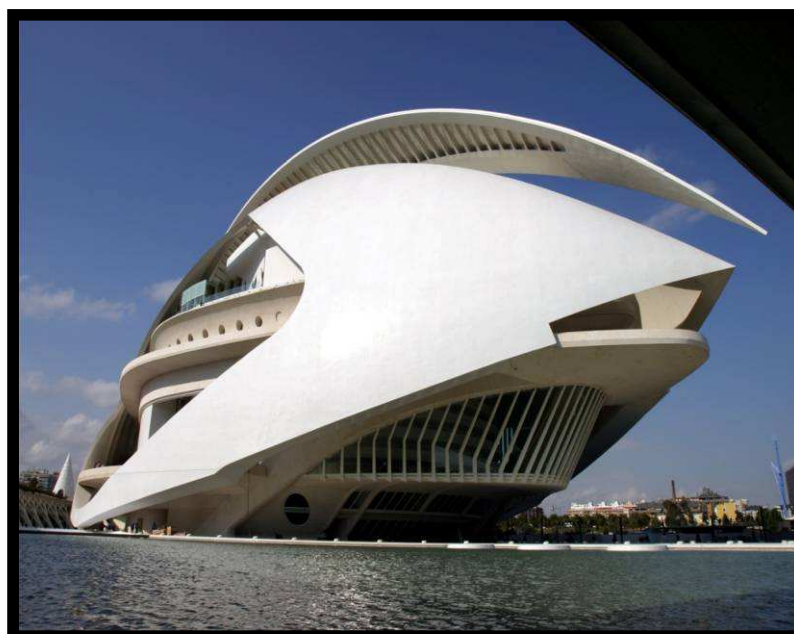
Protección mediante mallas del Palau de les Arts en Valencia.
