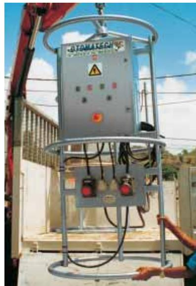
Protección específica contra los choques en armarios móviles
