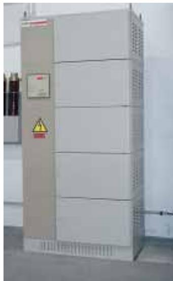
**Batería de condensadores en armario, con disparo automático en gradiente**
