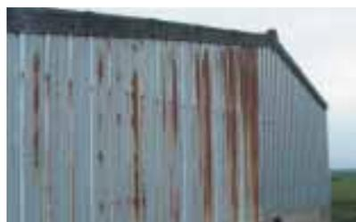
Revestimiento catódico al final de la vida útil. La capa de zinc (galvanización) se ha consumido completamente en algunos lugares, dejando al descubierto el metal de base.
