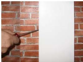
Canales protectoras cuya **tapa sólo se puede abrir con un útil**, según REBT ITC-BT 15 pto. 1
