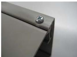
La cubierta de la canal **se puede precintar** mediante tornillos u otros medios equivalentes para evitar manipulaciones indebidas.
