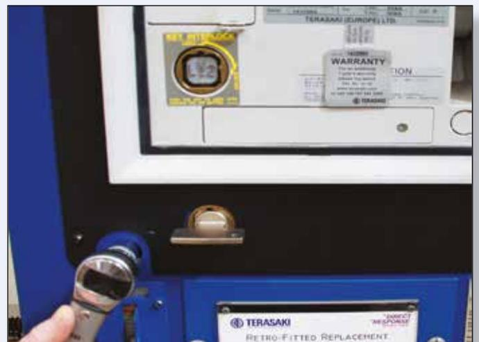
Los elementos funcionales extraíbles y los enclavamientos de seguridad de los mecanismos originales pueden conservarse y mejorarse. Incluso los mecanismos de tipo fijo pueden ser reemplazados por mecanismos extraíbles.
