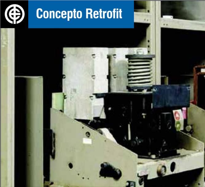
El retrofit se basa en la incorporación de nueva tecnología a sistemas antiguos. Los ACBs de retrofit pueden sustituir interruptores y disyuntores envejecidos e inseguros.
