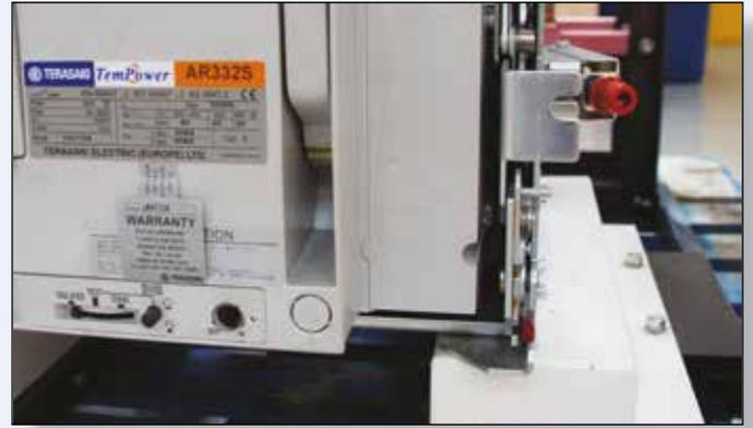
Los soportes de montaje son diseñados y fabricados a partir de las mediciones realizadas en la instalación para asegurar una integración mecánica perfecta. En la medida de lo posible, nuestros diseños tienen en consideración las ubicaciones originales de montaje en el cuadro, evitando así cortar y taladrar *in situ*.
