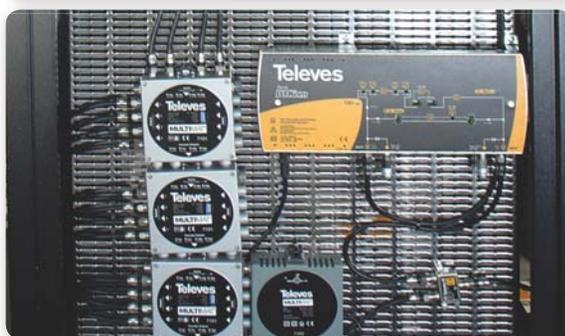
Todo el cableado y conexionado se realiza dentro del armario.
