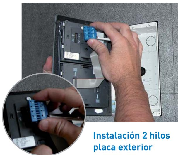
**Instalación 2 hilos placa exterior**
