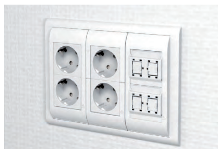
Acabado final en una instalación empotrada.
