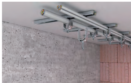
Montaje en el techo.
