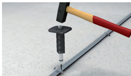
Instalación mediante botador (1).
