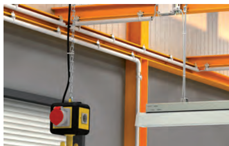
Fijación de cables en cadenas de suspensión.
