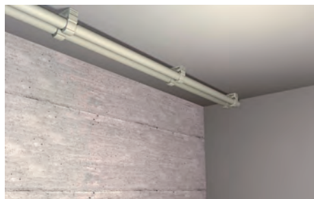
Instalación en techo.
