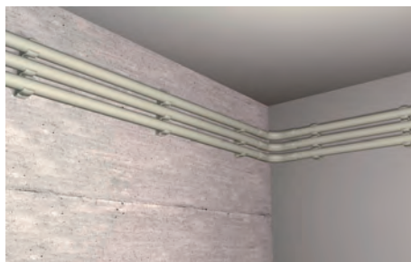
Instalación en pared.
