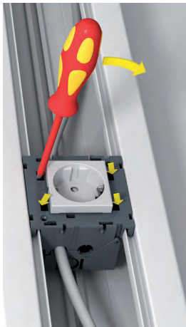
Montaje de portamecanismos.
