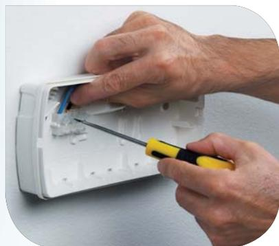
Amplio espacio para manipulación y reserva de cables. Conexión mediante bornas de tornillo de 2 x 2,5 mm<sup>2</sup>.
