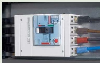
Uso de un manguito en un DPX 250 cableado
