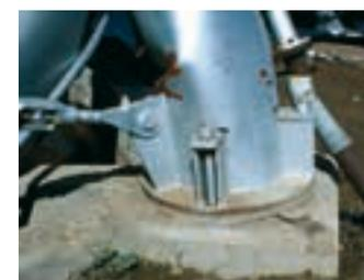
Figura 6: Anclaje químico de una carpintería metálica tras un evento sísmico.
