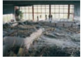
En 1985, en Uster, Suiza, cedió el falso techo de cemento de una piscina cubierta. Las suspensiones del techo de acero inoxidable no mostraban externamente ninguna imperfección, pero internamente la corrosión bajo tensión había causado la destrucción parcial del mismo.
