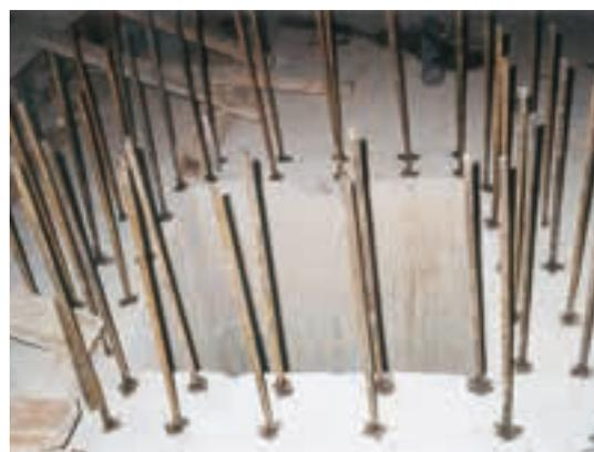
Las resinas de inyección fischer FIS V, FIS VS y FIS VT (vinil éster), así como la resina epoxy FIS EM han sido presentadas hasta aquí como medio de fijación para varillas roscadas, pero existe otro extenso campo de aplicación que es el de la fijación de barras corrugadas, ya sea como anclajes, o bien como esperas de conexión entre estructuras de hormigón nuevas y antiguas.
