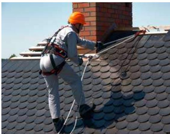
Las líneas de vida verticales temporales o de cuerda son muy útiles en multitud de aplicaciones. Sólo es necesario anclarlas en su parte superior. En caso de caída el dispositivo deslizante se bloquea sobre la cuerda.
