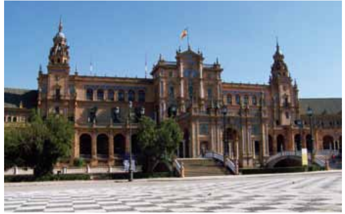
Plaza de España, Sevilla. Pararrayos con sistema de cebado.
