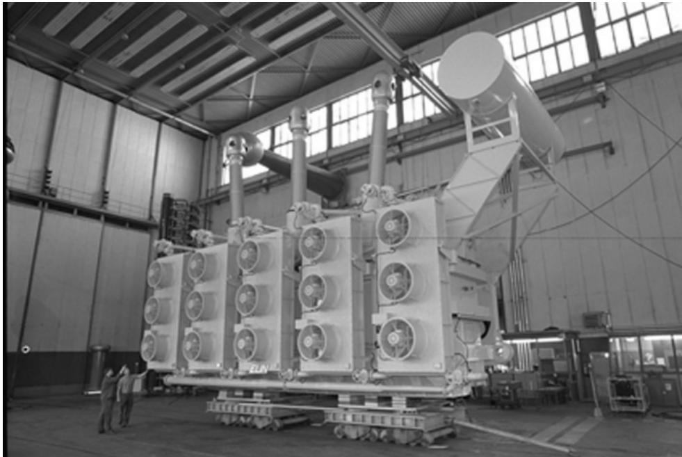
Transformador de gran potencia
