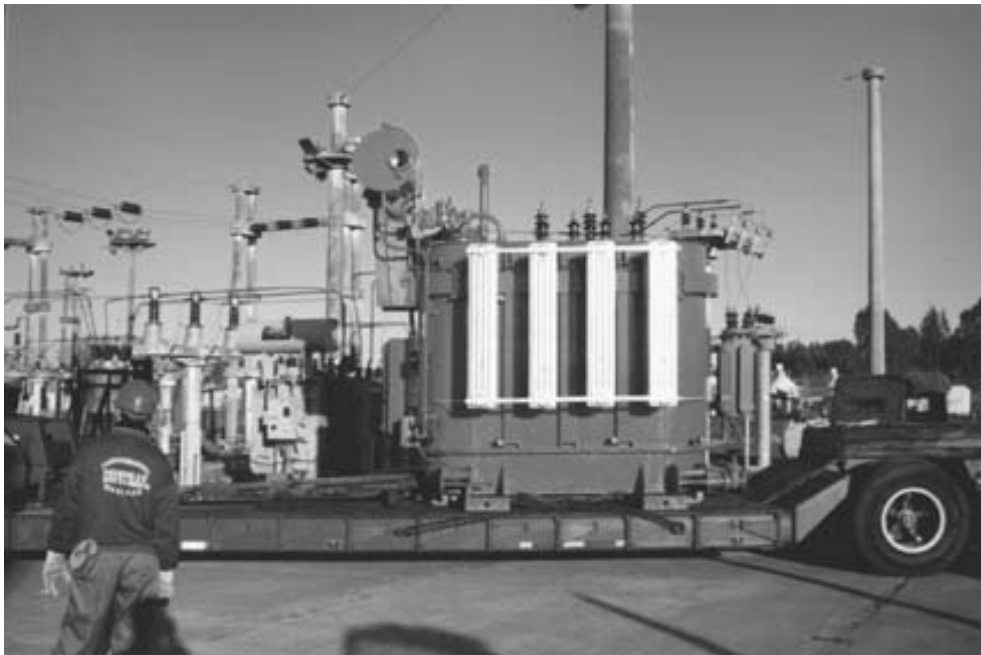
Transporte de transformadores de potencia
