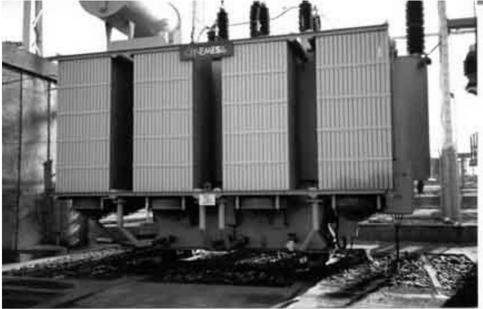
Transformador de potencia
