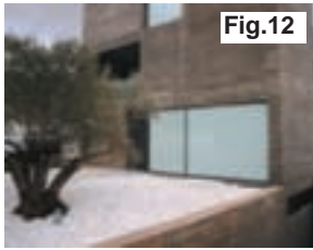
Detalle del exterior de la vivienda donde se aprecian los estores motorizados.
