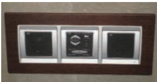
Sirena interior DN-62 integrada en un marco con un radio k-23 en una de las habitaciones.
