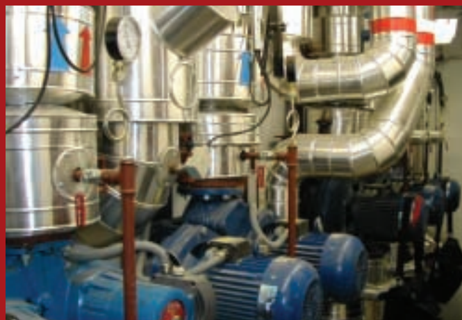
Impulsión a vivienda.
