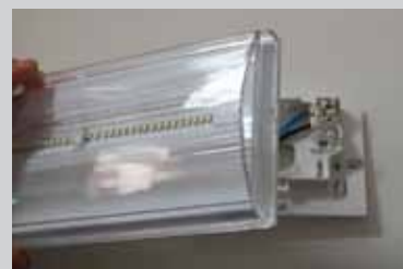
Montaje de luminaria
